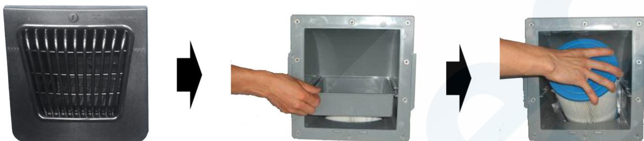
1. Desapertar o parafuso e retirar a tampa do skimmer deslizando-a para cima, **não a puxe para fora**.
